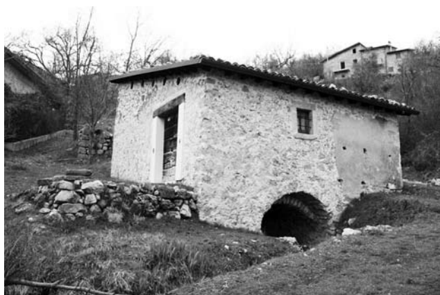
Fig. 1. La mola Martorelli completamente ristrutturata.
