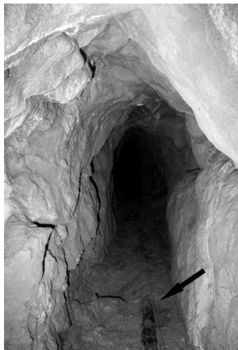
Fig. 2. Tubi in ghisa all'interno del cunicolo di monte Frontino.
