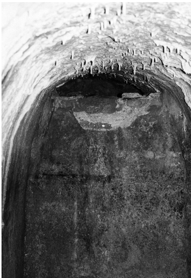
Fig. 8. Casarino, cisterna a cunicolo, muretto trasversale.
