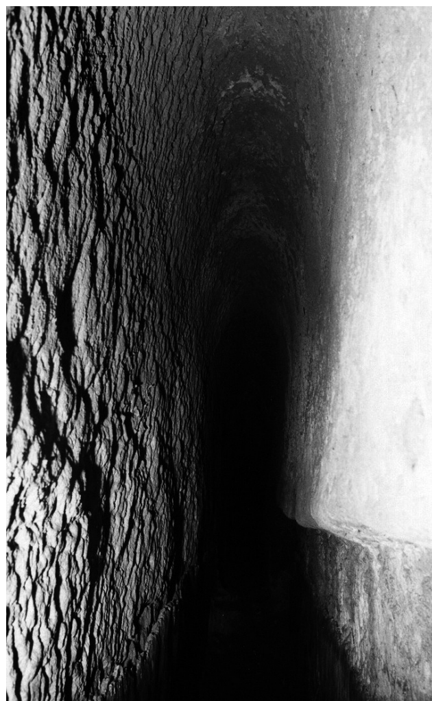
Fig. 7. Casarino, cunicolo principale.
