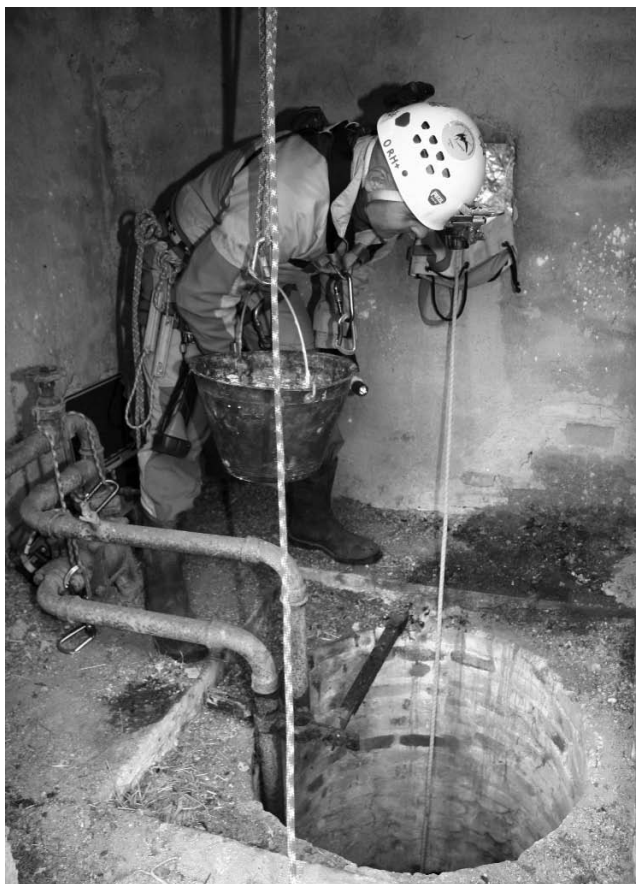
9. Operazioni di scavo all'interno del pozzo.
