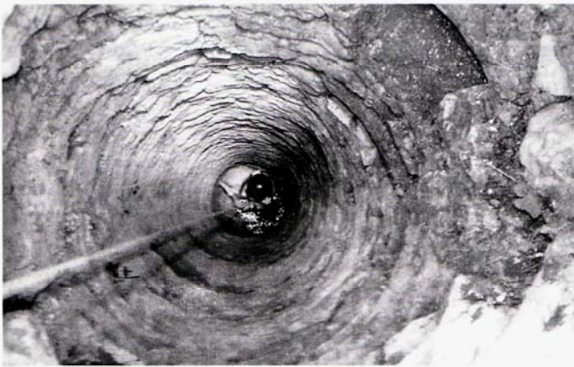
Fig. 8. Pozzo circolare di accesso al secondo acquedotto.
