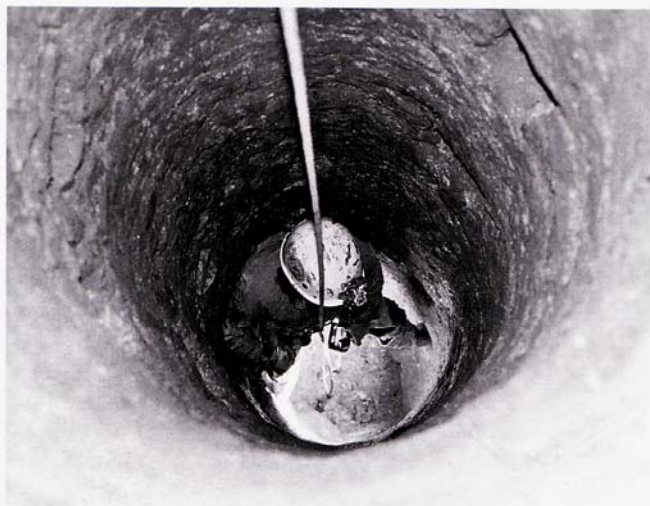
Fig. 8. Monteleone Sabino. Anfiteatro. Pozzo di accesso al sistema di adduzione e drenaggio idrico.
