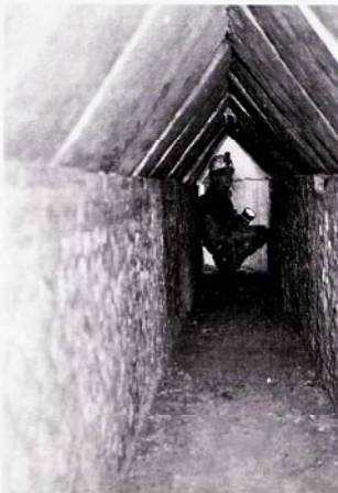
Fig. 9. Monteleone Sabino. Anfiteatro. Cunicolo anulare esterno.
